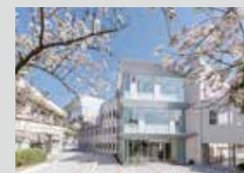
E 8号館(2023年4月完成)
